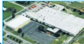
Usine de Sumter (États-Unis)
