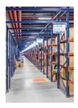
La stratégie omnicanal de Decathlon a conduit Mecalux à mettre en place des solutions de stockage permettant de dynamiser la préparation des commandes tout en optimisant l'espace disponible : des rayonnages à palettes, une mezzanine et des rayonnages pour picking. Une plus grande capacité se traduit par une amélioration du flux opérationnel et une hausse de la productivité lors qu'il s'agit de réduire les délais de livraison, un point essentiel à la satisfaction des clients en ligne.
