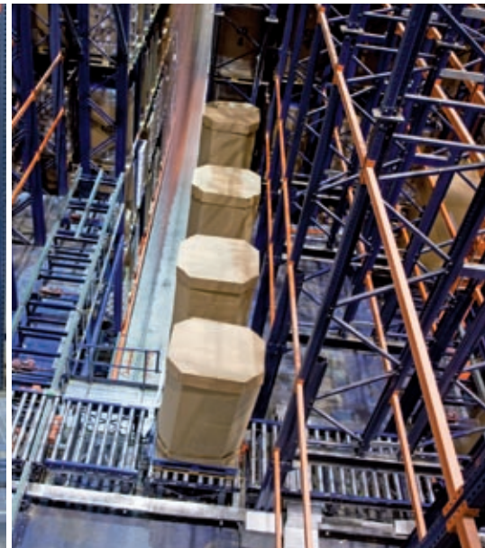
Convoyeurs pour allée de stockage.
