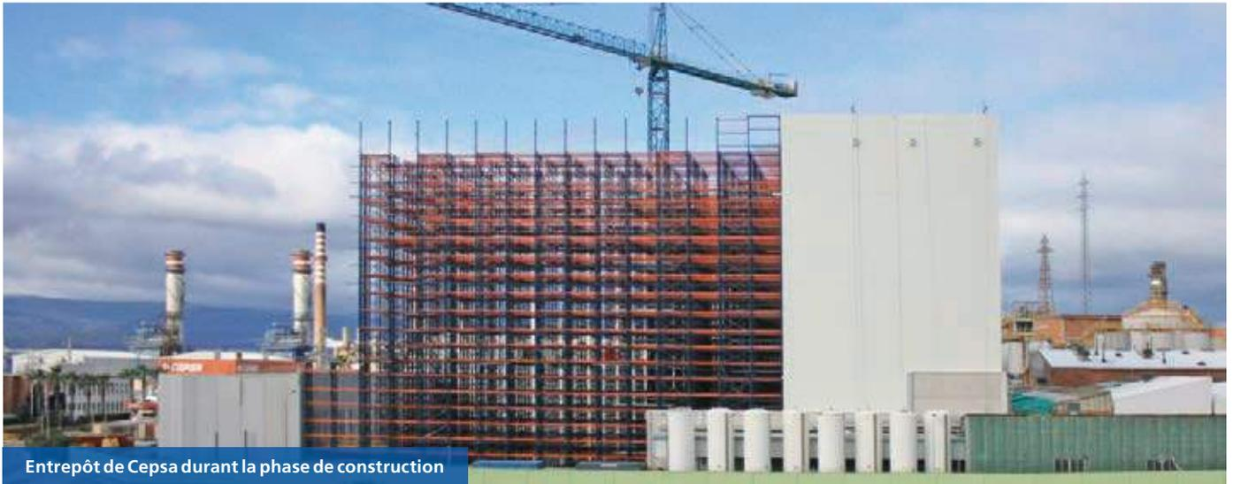
**L'entreprise du secteur énergétique Cepsa a confié à Mecalux la construction, pour son usine de lubrifiants, d'un entrepôt automatique autoportant clé en main d'une hauteur de 37 mètres, dans l'agglomération de San Roque (Cadix). La prestation comprenait également le logiciel Easy WMS de Mecalux, chargé de gérer toutes les activités du centre.**
