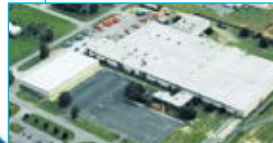
Usine de Sumter (États-Unis)
