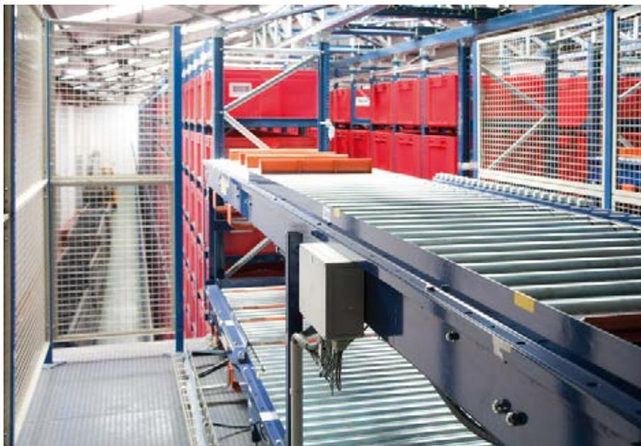
Mecalux a installé un magasin automatique miniload d'une capacité de plus de 14 200 caisses, avec système de convoyage à deux niveaux : la partie inférieure étant dédiée au picking et la partie supérieure au réassort
