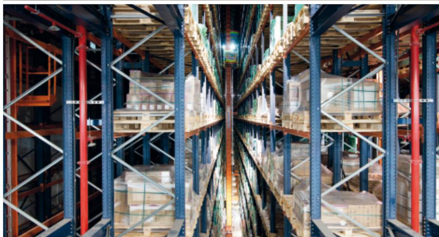
Mecalux a installé pour Ceramika Paradyż un entrepôt automatique autoportant d'une capacité de plus de 20 200 palettes dans la commune de Tomaszów Mazowiecki (Pologne). En périphérie de l'entrepôt se trouve un bâtiment de deux étages qui permet d'organiser efficacement l'entrée et la sortie de la marchandise, tout en accélérant les opérations de préparation des commandes. Le logiciel de gestion d'entrepôt EASY WMS de Mecalux pilote l'installation.
